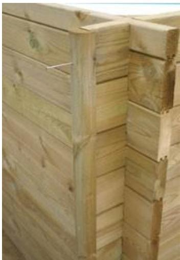
Figure 20 - Profil de finition en pin
