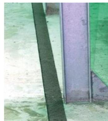
Figure 7 - Mise en place des bandes bitumineuses
