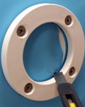
Effectuez les découpes des buses de refoulement et de prise balai (pour le modèle Odysséa). A l'aide d'un cutter, découpez soigneusement le liner en vous appuyant sur l'intérieur du corps de buse.
