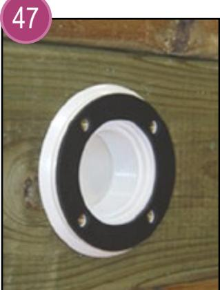
Avant de procéder à la pose du liner, collez un des 2 joints (skin pièces à sceller) adhésifs rectangulaires autour de la fenêtre du skimmer. Vérifiez que les perçages du joint soient bien en correspondance avec ceux du skimmer.
