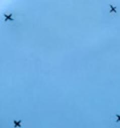
Repérez à travers le liner les quatre points de vissage du corps de buse.
