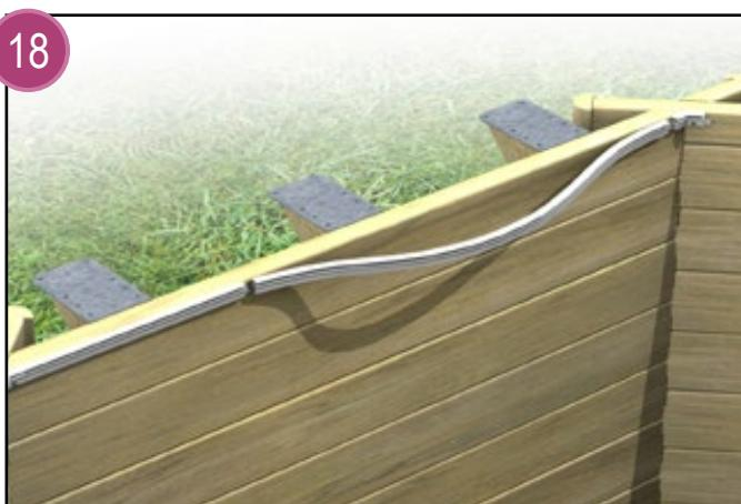
Emboîtez la section longue dans la pièce d'angle opposée à la jonction. Exercez une flexion sur le rail d'accrochage de manière à emboîter celui-ci dans la pièce de jonction. Fixez le rail à l'aide d'une vis à 2 cm de chaque extrémité. Puis complétez la fixation par environ une vis tous les 20cm.
