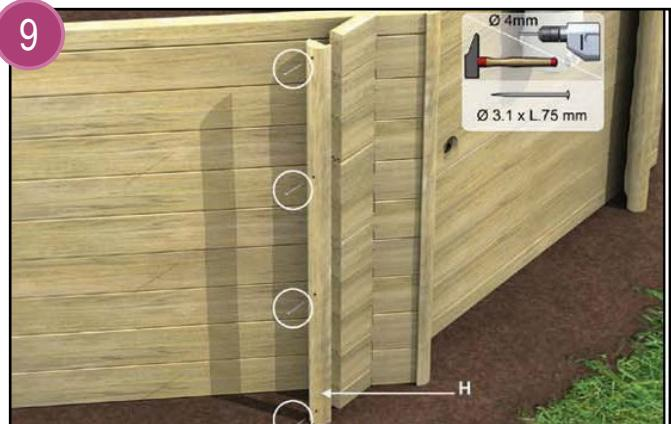
Avant de poser les profils de finition, il faut poser dans chaque angle un renfort.
