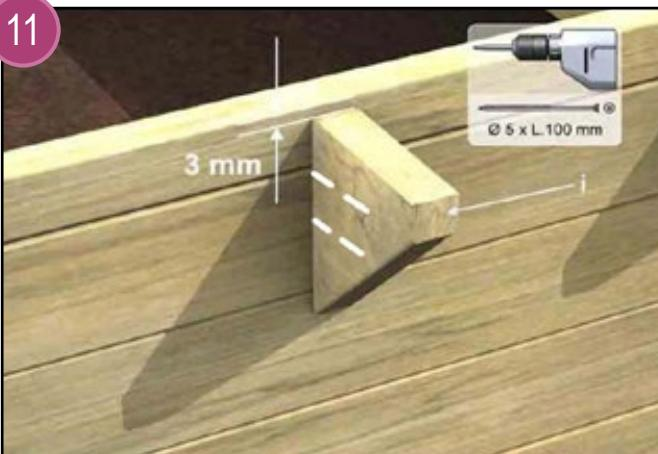
Les consoles sont destinées à soutenir la margelle qui sera mise en place après le remplissage du bassin. Fixez, après avoir pré-percé les parois par l'intérieur de la piscine, chaque console (type I) à l'aide de 2 vis (5x100m sachet I) en prenant soin de les positionner à 3mm sous la partie supérieure de la structure. Après le vissage prenez soin d'éliminer toute écharde éventuelle.
