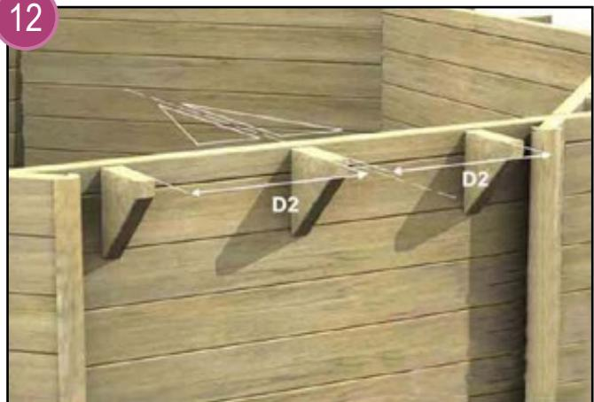
Les consoles sont au nombre de 3 par pan (sauf pan recevant le skimmer). Positionnez 1 console au centre de la lame, les 2 autres sont positionnées de part et d'autre (côte D2 =58cm).
