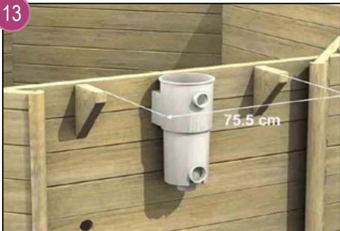
Sur la paroi recevant le skimmer, les consoles au nombre de 2 sont positionnées à 75,5 cm l'une de l'autre, de part et d'autre de l'axe du skimmer.
